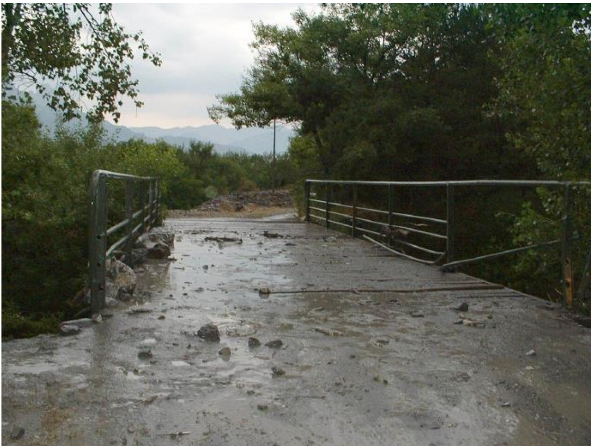
fig. 1 : Pont de Briançon en 2003 – Vue depuis la rive gauche
